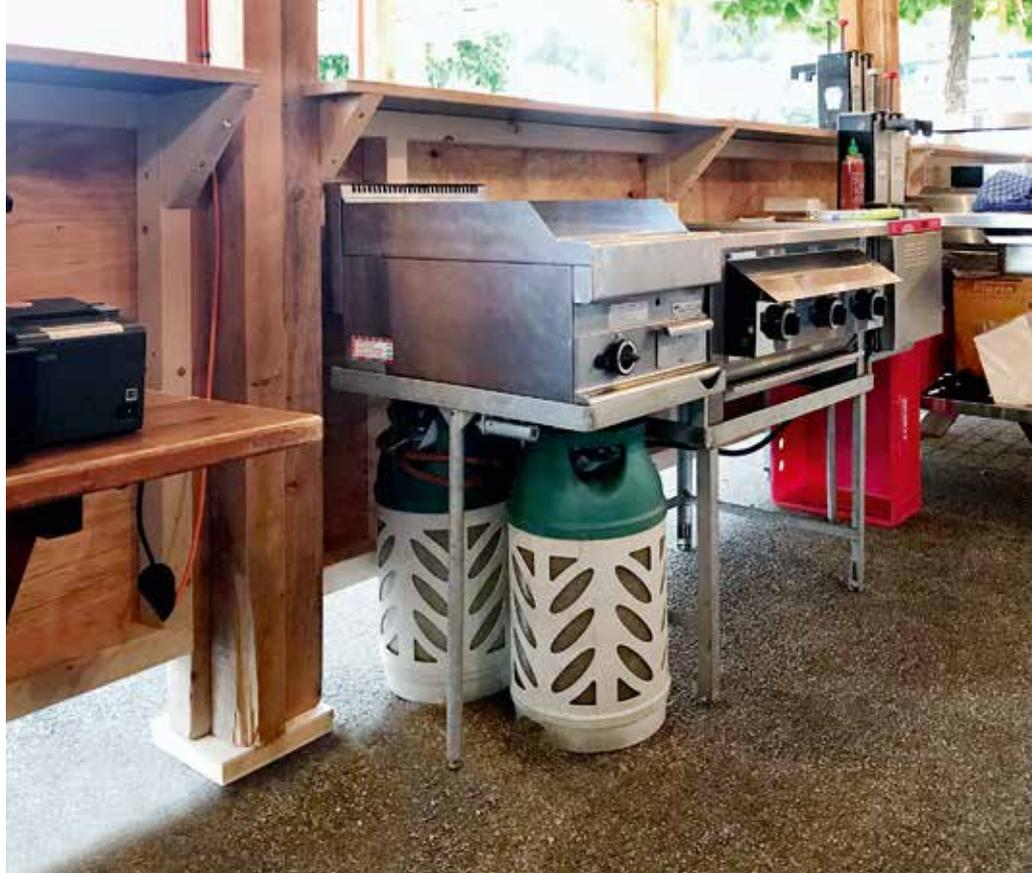
Gli impianti a gas liquefatto impiegati in occasione di manifestazioni devono essere controllati ogni anno e, una volta superato il controllo, vanno contrassegnati con un'etichetta (cfr. riquadro a sinistra, in basso).
