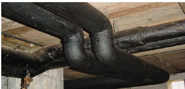
Bitumenbeschichtung
