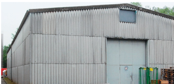
Asbesthaltige Wellplatten
