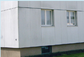
Asbesthaltige Fassadenplatten
