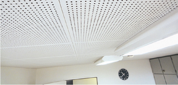
Deckenplatten bei abgehängten Decken
