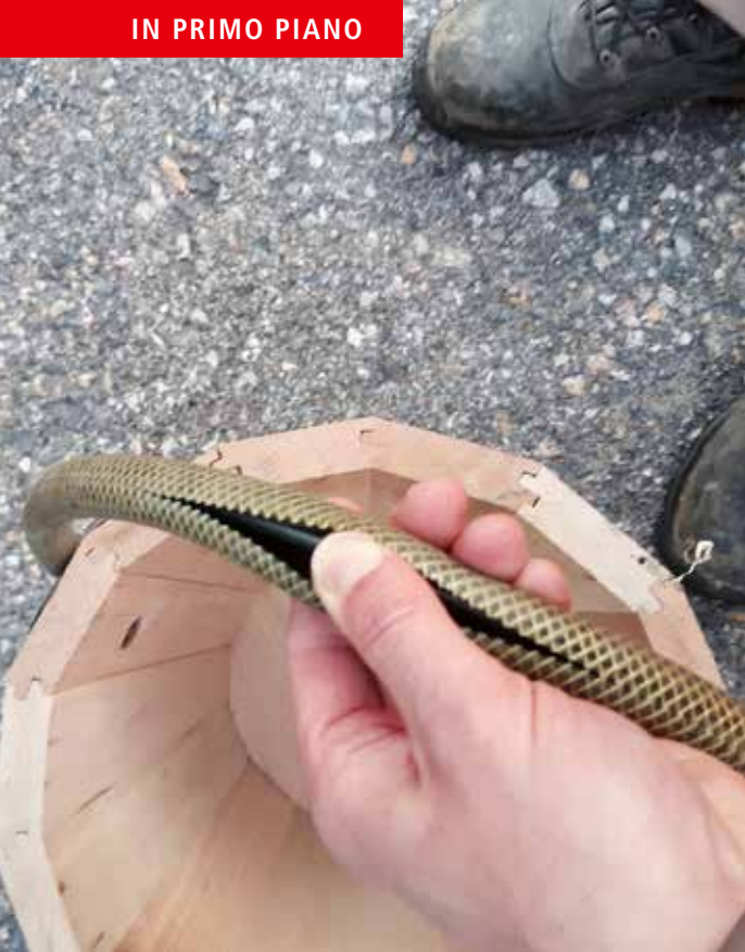
Implementazione del suggerimento di un lavoratore: un involucro di plastica intorno al manico del secchio per asfalto per ridurre la conduzione del calore dell'asfalto caldo.
