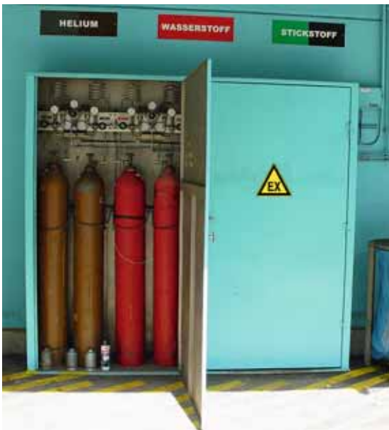
Figura 4: distribuzione centralizzata di gas
