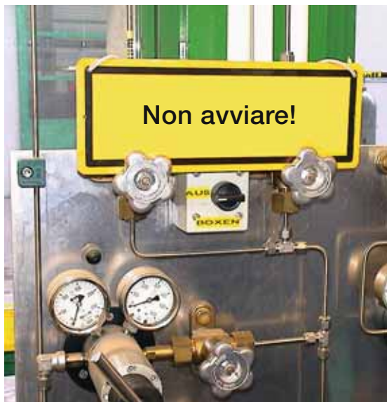
Figura 25: identificazione di un impianto non pronto per l'uso
