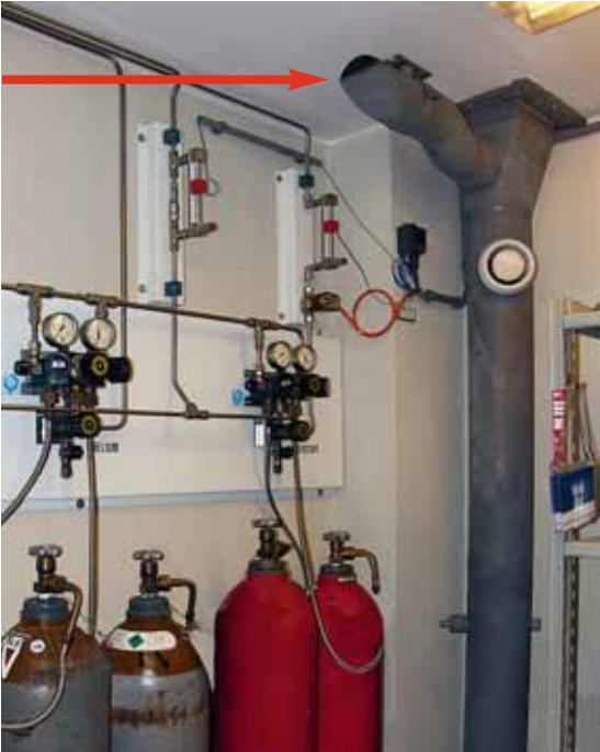
Figura 19: aspirazione lungo il soffitto
