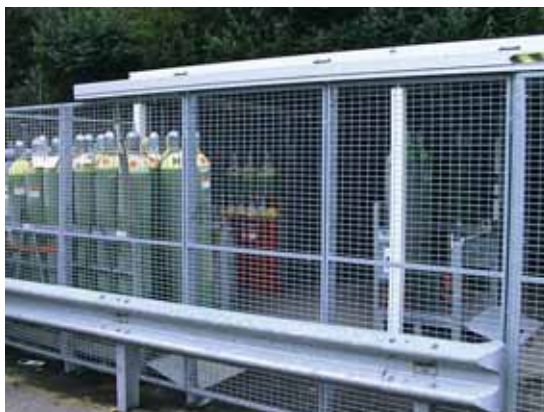
Figura 13: protezione contro i tamponamenti
