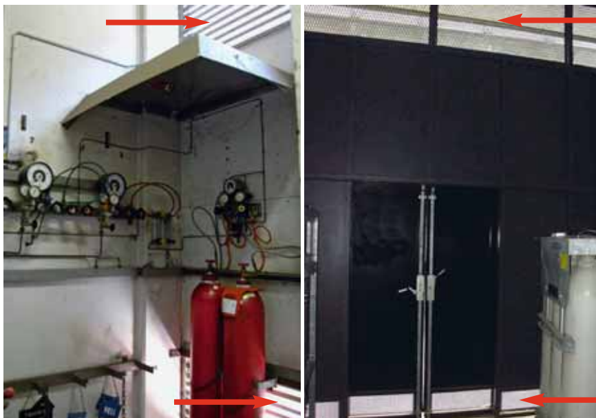
Figura 18: aperture per la ventilazione naturale
