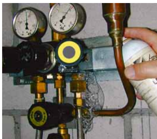
Figura 26: controllo di ermeticità dell'impianto
