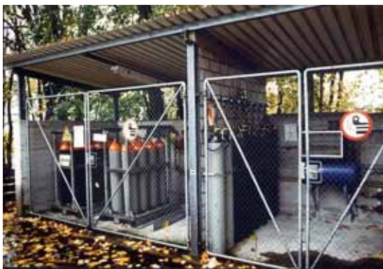
Figura 20: collocazione separata tramite parete
