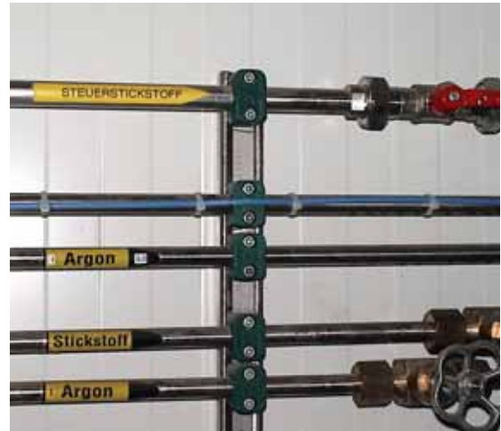
Figura 9: identificazione delle condotte
