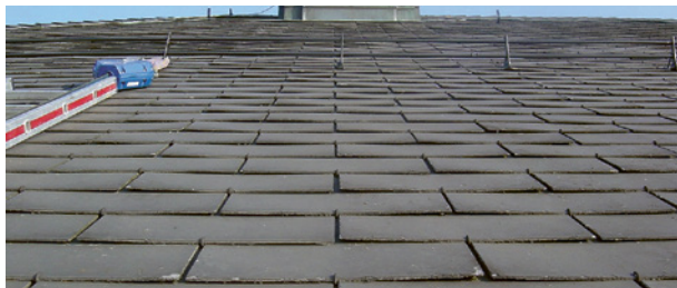
Tetto in ardesia
