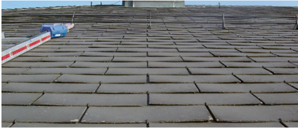
Tetto in ardesia
