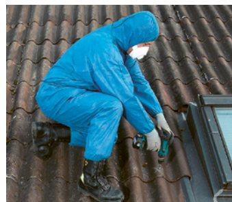
Sostituzione degli abbaini
