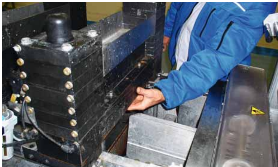
01 // Il dipendente stava cambiando le lame alla stazione di taglio. In quel frangente la macchina poteva avviarsi nonostante i ripari fossero aperti, in quanto il relè di sicurezza era stato manipolato (scena ricostruita). // Foto: Suva
