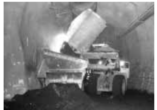
Figura 3: sgombero del materiale di scavo (marino) con caricatrice su ruote gommate. Quando si sceglie il SFA, è necessario tenere conto di come verrà utilizzato il mezzo.
