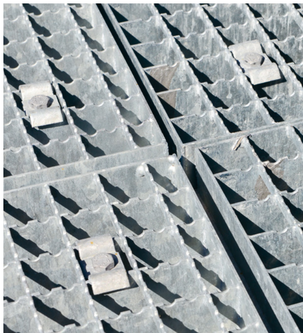
10 Ogni elemento del grigliato è saldamente fissato e non può essere spostato in maniera accidentale.
