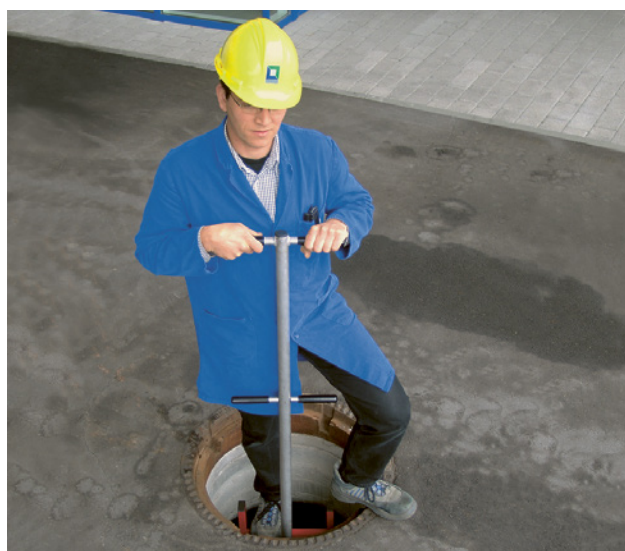
27 Discesa in un pozzo con l'aiuto di un dispositivo di trattenuta (altezza minima di 1 m)
