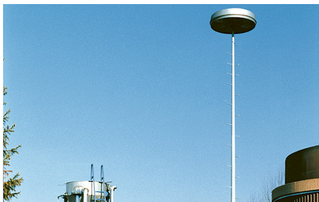
22 Una buona illuminazione contribuisce a eseguire in sicurezza i lavori necessari, ad esempio in caso di guasti, anche di notte.
