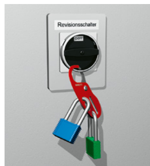
2 Interruttore per la revisione con disinserimento diretto
