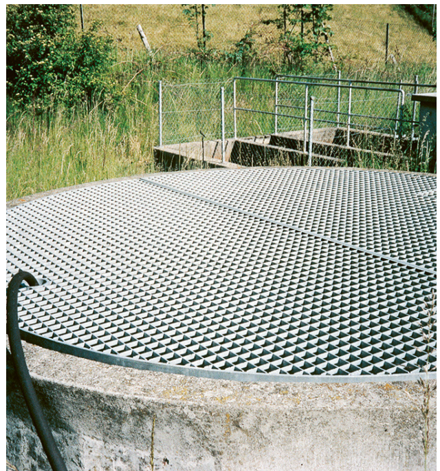
12 Grigliati e coperture devono essere realizzati con materiali resistenti, ad esempio acciaio o plastica.
