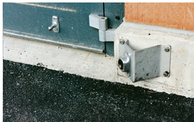
23 Se applicato sulla parete, il fermaporte non costituisce più un punto di inciampo.
