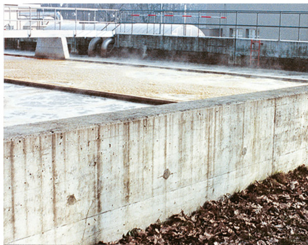
16 Muretto perimetrale del bacino, rialzato di almeno 110 cm sul terreno
