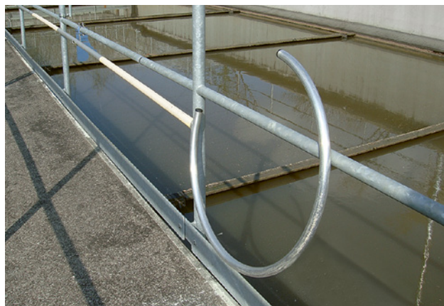
32 Pertica salvagente, preferibilmente in materiale galleggiante, con estremità a uncino
