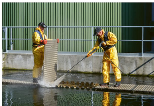
33 Protezione con giubbotti di salvataggio quando si lavora oltre un parapetto e in prossimità di bacini pieni.
