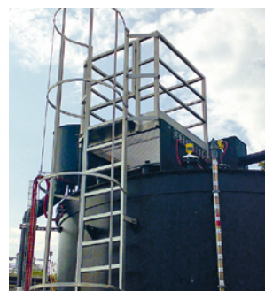
25 e 26 Scale fisse a pioli con gabbia di protezione dorsale e pianerottolo intermedio. Il piano di accesso è messo in sicurezza con una porta a chiusura automatica, il bordo del tetto con un parapetto.
