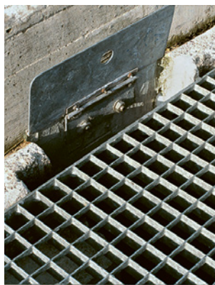
19 e 20 Lo spazio vuoto non utilizzato nel grigliato può essere chiuso con una serranda.
