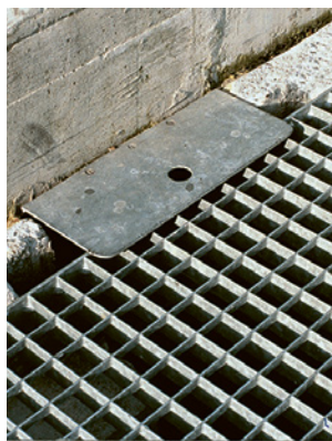
19 e 20 Lo spazio vuoto non utilizzato nel grigliato può essere chiuso con una serranda.
