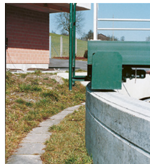
15 In seguito all'abbassamento del terreno, il muretto perimetrale del bacino svolge la funzione della protezione anticaduta alta 110 cm.
