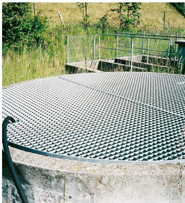
12 Grigliati e coperture devono essere realizzati con materiali resistenti, ad esempio acciaio o plastica.
