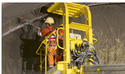
2 Mise en place des mesures de sécurité dans la zone sécurisée
