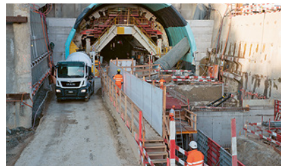
3 Les voies piétonnes sont clairement séparées des voies de circulation.
