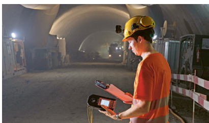
1 La qualité de l'air sur le chantier doit être régulièrement mesurée.
