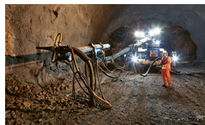
3 Éclairage du poste de travail
