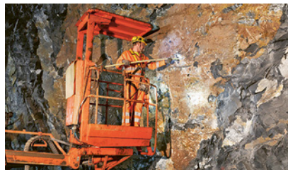
2 PEMP utilisée pour réaliser des travaux en hauteur
