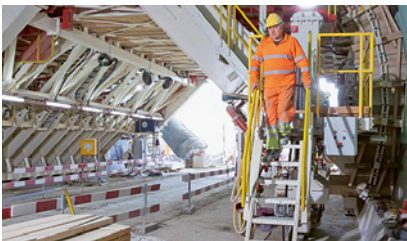
1 Escalier équipé d'une main courante
