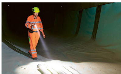
2 Lampe de mineur utilisée comme éclairage de secours
