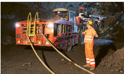
1 Toujours garder le contact visuel avec les conducteurs d'engins de chantier.
