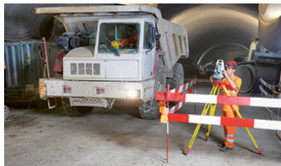
2 Signalisation indispensable, y compris pour les travaux de courte durée
