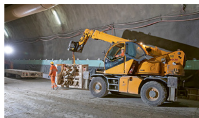
3 Accompagnement d'une charge transportée au moyen d'un engin de chantier
