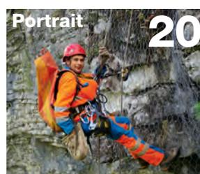
**Sur les hauteurs:** Urs von Bergen travaille jusqu'à 300 m du sol et il préfère «contrôler chaque nœud deux fois plutôt qu'une». Le technicien cordiste passe jusqu'à neuf heures par jour suspendu à une falaise pour dégager des pierres et des blocs descéllés.
