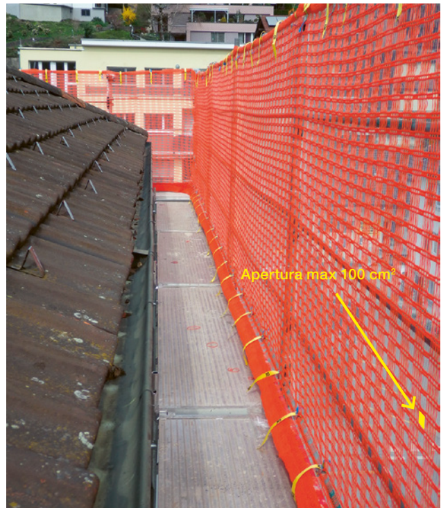
1 Parete di protezione da copritetto corretta e testata secondo la norma SN EN 13374 con rete che delimita il ponte da lattoniere e cinghie di fissaggio.
