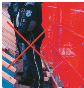
5 La polizia e le autorità inquirenti indagano sulla causa di un infortunio: la parete di protezione da copritetto è difettosa e fissata in modo non corretto usando fascette serracavo.
