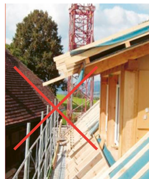
6 e 7 Evitare assolutamente pareti di protezione da copritetto inefficaci.
