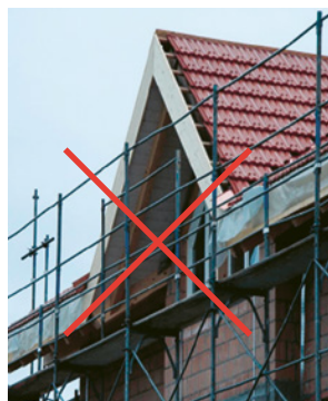
6 e 7 Evitare assolutamente pareti di protezione da copritetto inefficaci.
