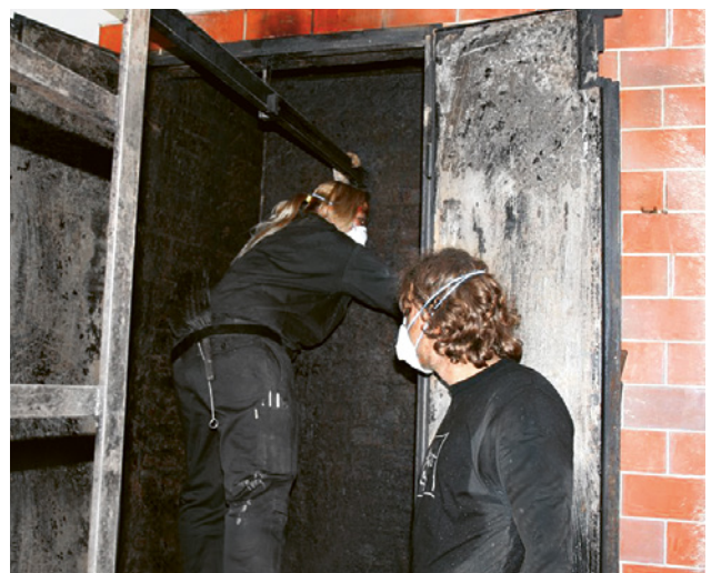
Fig. 6 Surveillance des personnes: une personne se trouve dans la chambre de combustion (chambre à fumée), la deuxième personne la surveille de l'extérieur.
