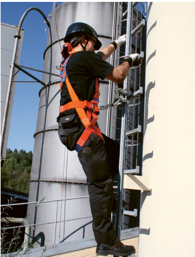
Fig. 7 Cheminée d'usine: protection contre les chutes au moyen d'une échelle installée à demeure et d'un dispositif antichute pour l'ascension.
