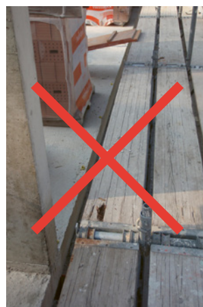
Figure 2 e 3 I piani che presentano fessure o tagli devono essere sostituiti.
