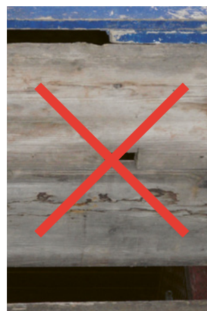
Figure 2 e 3 I piani che presentano fessure o tagli devono essere sostituiti.
