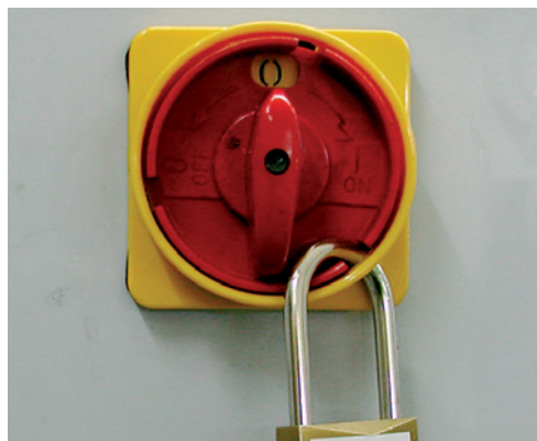
1 Interrupteur de sécurité cadenassable
