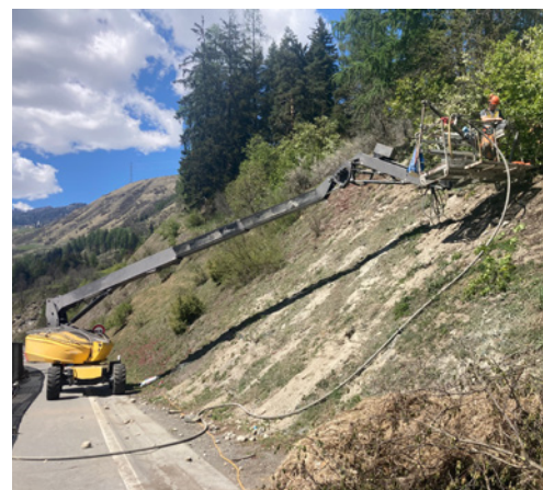
5 Accesso sicuro alla slitta di perforazione con piattaforma di lavoro elevabile
