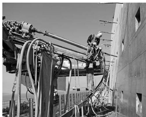
Fig. 5: bisogna garantire un accesso sicuro alla slitta di perforazione.
