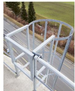
**4** Sicherer Leiterausstieg mit selbstschliessender Durchgangssperre
