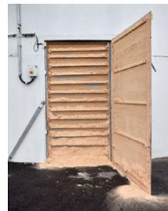
**3** Entnahmeöffnung mit schräg nach oben ausziehbaren Jalousiebrettern.
