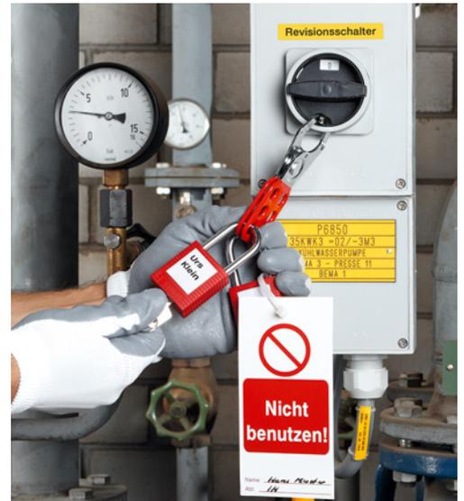
6 Sicherheitsschalter, der sich mit persönlichem Vorhängeschloss sichern lässt. Bei jedem Sicherheitsschalter muss angeschrieben sein, welchen Bereich der Anlage er abschaltet.
