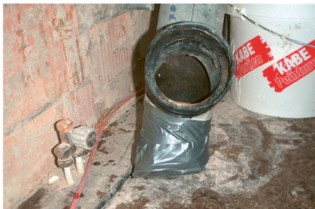
4 Tubo pronto per lo smaltimento, con estremità sigillata mediante nastro adesivo
