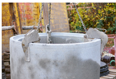
2 Accessori di sollevamento utilizzati correttamente per spostare gli elementi di un pozzetto.
