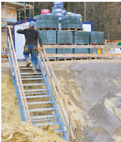
1 Accesso allo scavo di fondazione tramite una scala a rampa da cantiere
