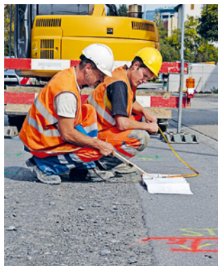
Regola 1 Pianificazione accurata dei lavori
