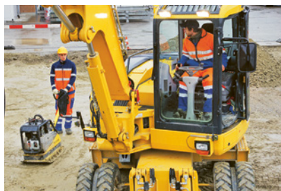
2 Lavoratore nella zona di pericolo di una macchina edile
