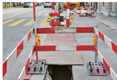
3 Passerella su uno scavo
