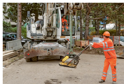
3 Movimentazione corretta di un carico con l'escavatore gommato
