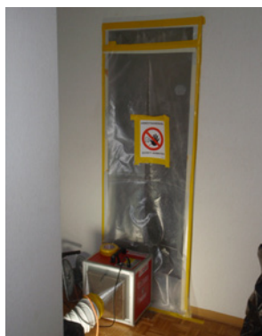
5 Zone d'assainissement confinée avec appareil de sous-pression
