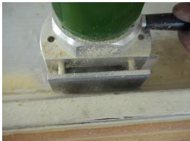
1 Enlèvement de mastic de fenêtres à la scie.
