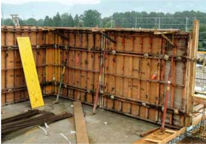
01 // Faux: les deux ouvriers qui travaillaient sur cette plateforme sont tombés sur le sol en béton. La protection latérale manquait aussi. // Photo: Suva
