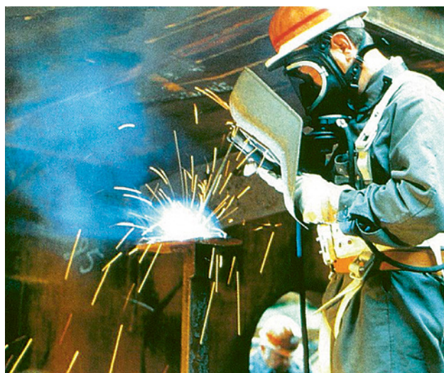
Figura 42 Saldatore equipaggiato di apparecchio di respirazione indipendente dall'ambiente per l'uso in spazi ristretti (ad es. locali interrati privi di finestre)
