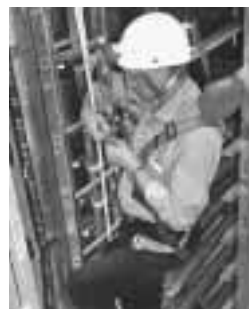
Figure 5: utilisation de matériel d'encordement approprié: - échelle avec antichutes mobiles, - dispositifs antichutes à rappel automatique sur le dos si le dysfonctionnement en question ne peut pas être éliminé à partir de l'échelle, - casque équipé d'une lampe frontale intégrée.
