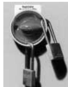
Bild 9: Bei Instandhaltungsarbeiten muss jeder Monteur über ein persönliches Vorhängeschloss verfügen, um den Sicherheitsschalter der Anlage abschliessen zu können.
