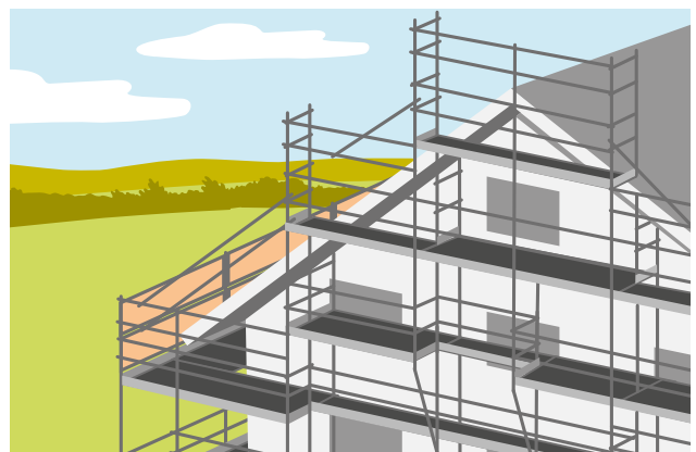
1 Kollektivschutz in der Bauphase
