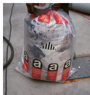
6 Sacco di plastica con la dicitura «Amianto»
