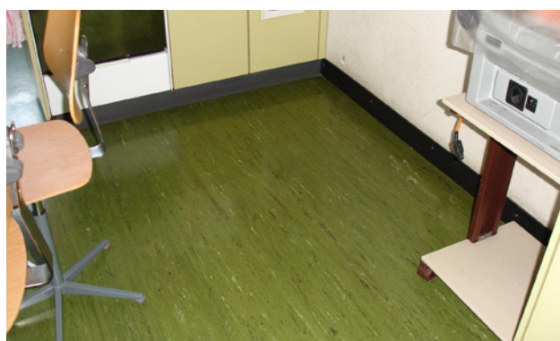
2 Anche in questo rivestimento elastico per pavimenti a strisce l'amianto è saldamente inglobato nella plastica.
