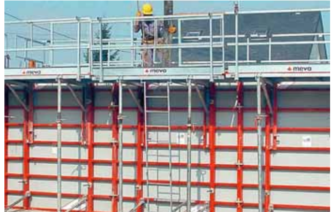
02 // Giusto: così si presenta un ponteggio montato correttamente con una protezione laterale a tre elementi. // Foto: zvg
