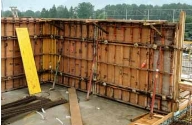
01 // Sbagliato: da questo ponteggio a mensole sono caduti i due operai finendo sul pavimento in cemento. Mancava anche la protezione laterale. // Foto: Suva
