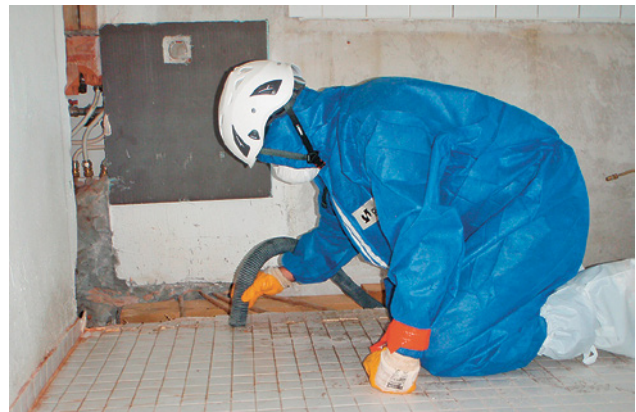
3 La zone d'assainissement est soigneusement nettoyée après le travail.
