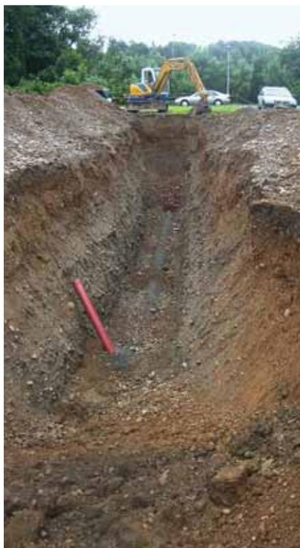
**01** // Lo scavo era più profondo di 1,5 m e per questo, stando all'ordinanza sui lavori di costruzione, avrebbe dovuto essere messo in sicurezza adottando adeguate misure (scarpata adeguata, puntellazione). // Foto: Suva
