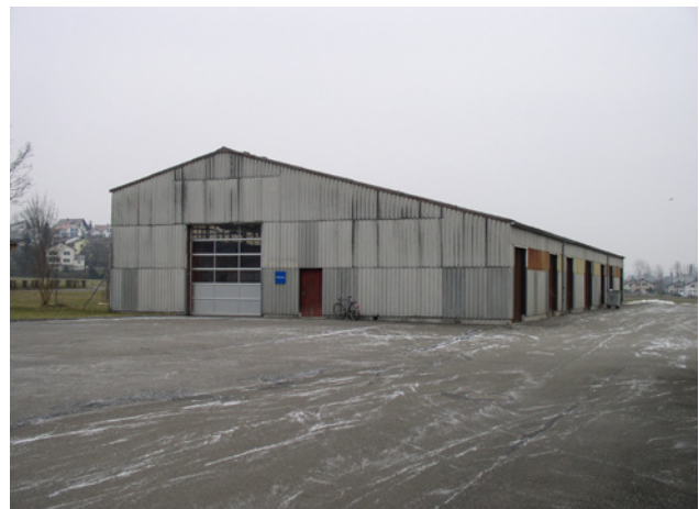
1 Halle industrielle composée de plaques ondulées en fibrociment
