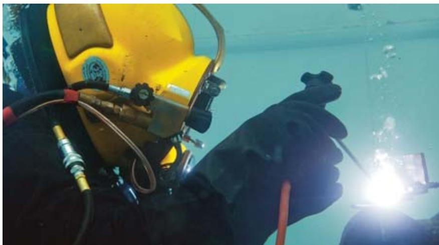
**Figure 6b** Travaux de soudage par plongeurs professionnels. Toutes les techniques de construction et de soudage utilisées sur la terre ferme, ou presque, sont aussi utilisables sous l'eau.
