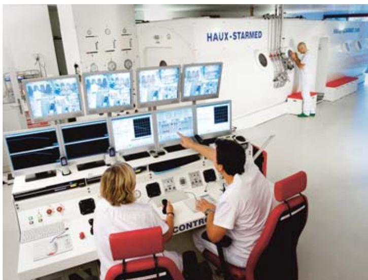
**Figure 24a, b** Caisson thérapeutique à l'hôpital, pouvant accueillir dans chaque unité 8 patients assis ou 3 couchés pour une ventilation à l'oxygène pur. Ce dispositif nécessite d'importants moyens de surveillance.
