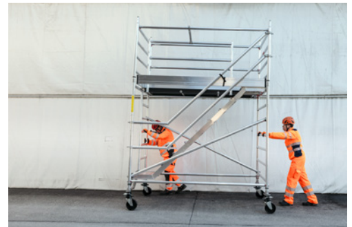
6 Il ponteggio può essere spostato solo dopo che tutte le persone sono scese.
