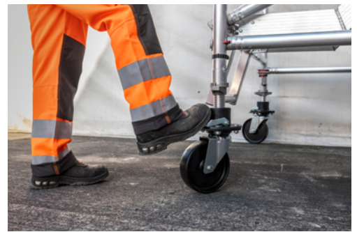
5 Per evitare lo spostamento accidentale del ponteggio bisogna bloccare le ruote.
