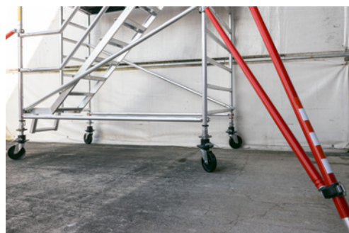
3 Ponteggio mobile su ruote posizionato su un piano di appoggio solido e resistente
