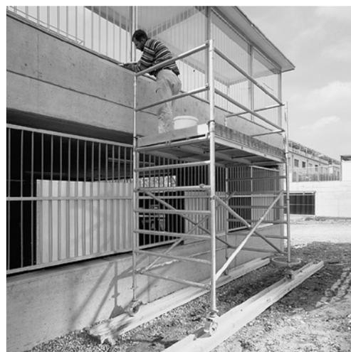
2 Un piano di appoggio solido impedisce il cedimento delle ruote.
