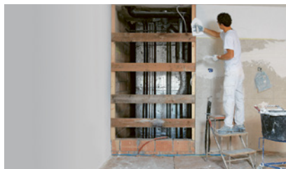
2 Vano tecnico messo in sicurezza
