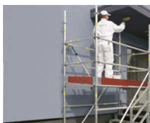
2 Rampa con ponteggio
