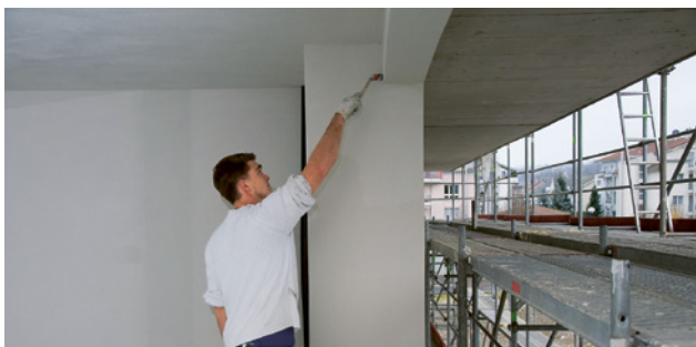
1 Ponteggio di facciata come protezione contro le cadute
