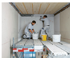
3 Vano scala con ponteggio
