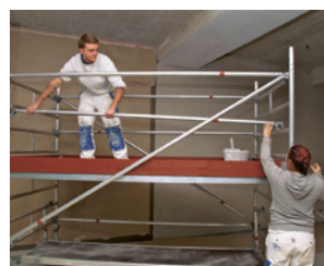
3 Protezione laterale sul ponteggio mobile su ruote
