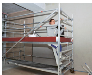
2 Accesso interno al ponteggio mobile su ruote
