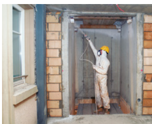
1 Vano ascensore con piattaforma
