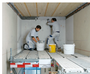
3 Vano scala con ponteggio
