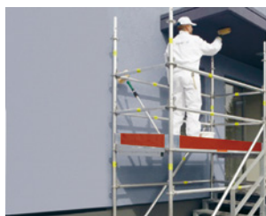
2 Rampa con ponteggio
