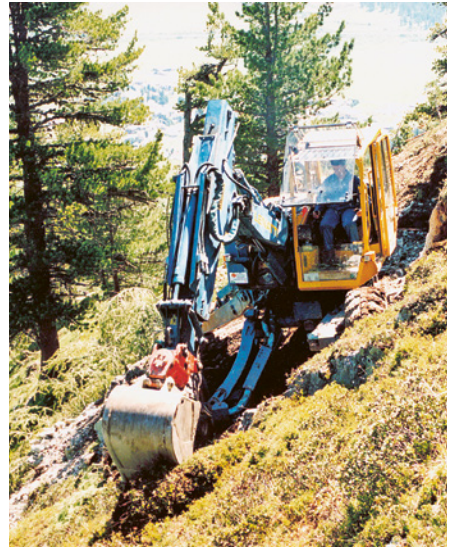
6 Les conducteurs d'engins doivent disposer des connaissances suffisantes pour pouvoir maîtriser de telles situations.
