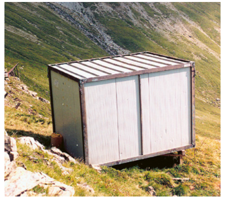
5 Ce baraquement est protégé de la foudre. Il est placé dans un endroit sûr à proximité immédiate du poste de travail.
