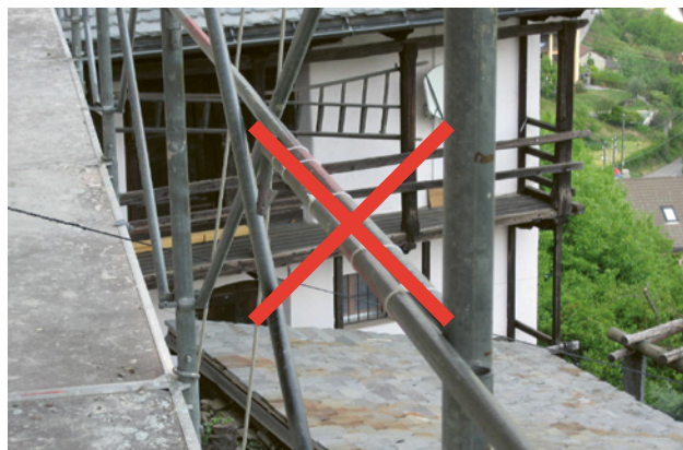
3 Les colliers de serrage en plastique ne sont pas assez résistants et sont donc interdits.
