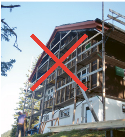
5 à 7 Échafaudages de façade non conformes et/ou lacunaires
