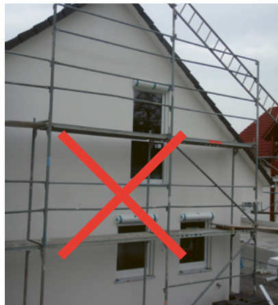
5 à 7 Échafaudages de façade non conformes et/ou lacunaires
