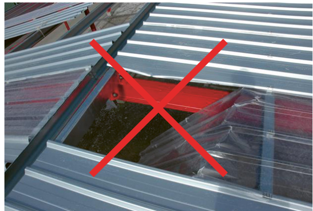
3 Ein Einsturz durch eine Lichtplatte muss verhindert werden.
