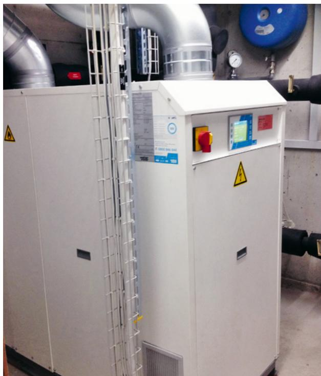
Sistema di refrigerazione in vano ventilato
