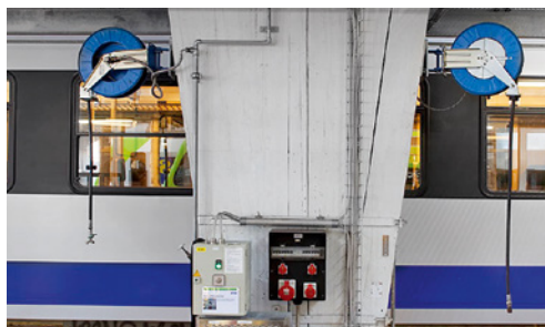
1 Una bobina avvolgicavo mantiene il posto di lavoro ordinato e non è di intralcio.
