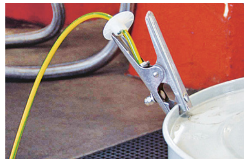
2 An einem Fassrand angebrachte Erdungsklemme
