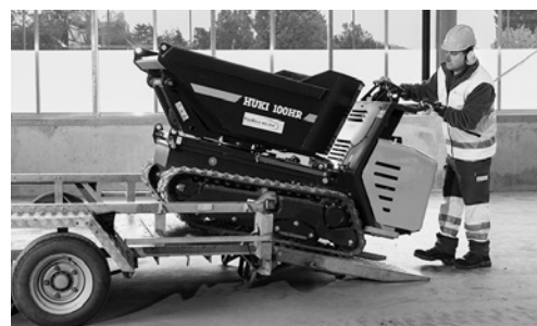
8 Carico della macchina sul rimorchio con rampa di accesso
