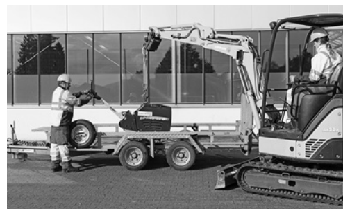
9 Operazione di carico con escavatore
