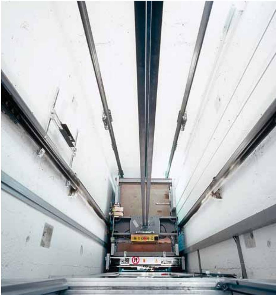
01 // Vue sur le toit d'une cabine d'ascenseur: le travail est autorisé uniquement lorsque la cabine est protégée contre tout risque de mouvement incontrôlé (risque de chute). // Photo: Suva
