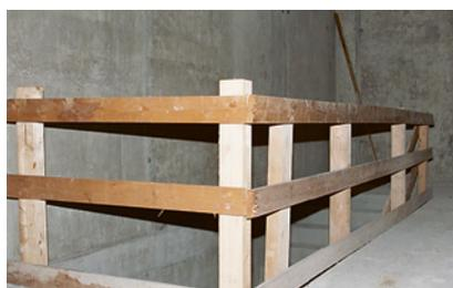
2 Risque de chute à l'intérieur d'un ouvrage (p. ex. ouverture pour cage d'escaliers).
