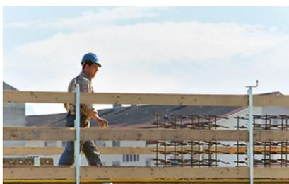
1 Risque de chute sur un coffrage de dalle (p. ex. interruptions de bétonnage).
