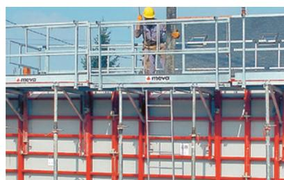
3 Risque de chute sur une plateforme de bétonnage.
