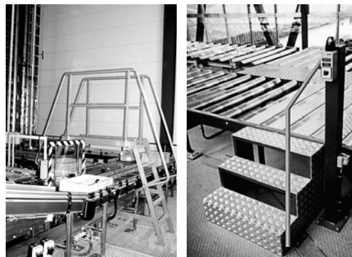
6 Passerelle au-dessus d'un convoyeur à rouleaux.
