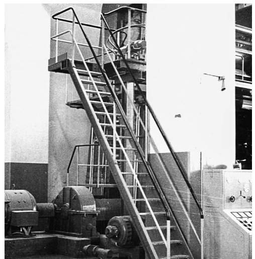
4 Escalier raide équipé d'un garde-corps de chaque côté.
