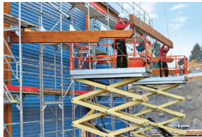
2 Montage von Tragwerken mit Hilfe einer Hebebühne
