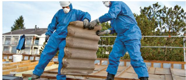
2 Bei Rückbauarbeiten dürfen asbesthaltige Faserzementplatten nicht bearbeitet werden.
