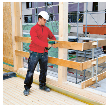
3 Wandöffnung mit Seitenschutz gesichert
