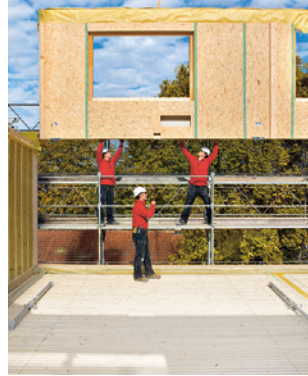
Regel 3 Mit Fassadengerüst arbeiten
