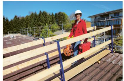
3 Nicht durchbruchssichere Dachflächen: Laufstege einsetzen.
