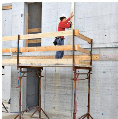
2 Bockgerüst mit korrektem Seitenschutz
