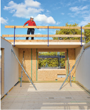
Regel 1 Absturzkanten sichern
