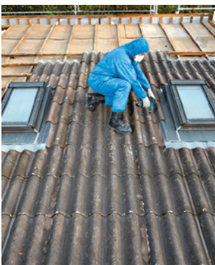
Regel 9 Vor Asbeststaub schützen
