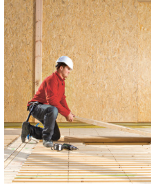
Regel 2 Bodenöffnungen schliessen
