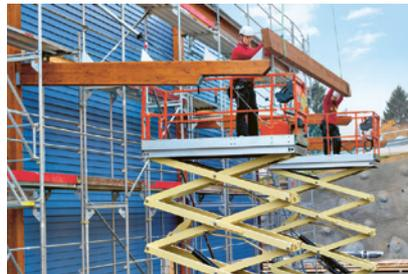
2 Montage von Tragwerken mit Hilfe einer Hebebühne
