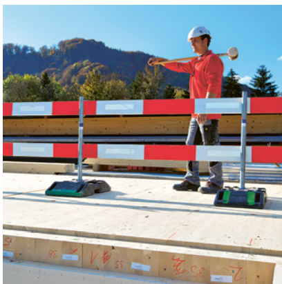
1 Zonenabschrankung: 2 Meter von der Absturzkante zurückversetzt
