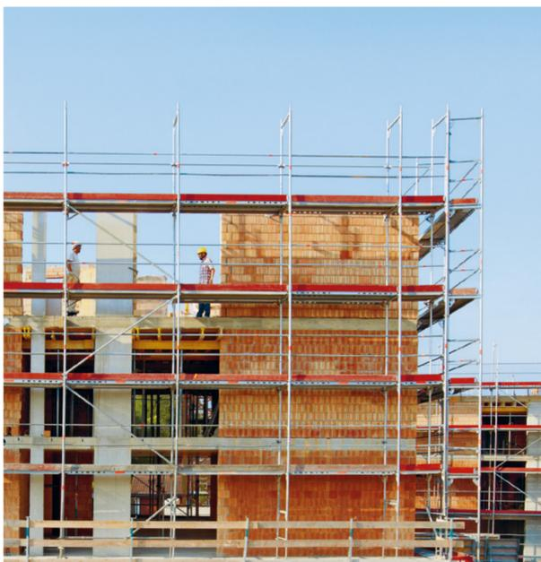
**Regel 4:** Wir arbeiten ab einer Absturzhöhe von 3 m nur mit Fassadengerüst.
