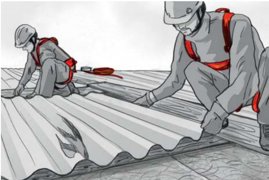
Fataler Fehlentscheid: Die Dachdecker verzichteten auf den Anseilschutz, weil ihr Seil zu kurz war.
