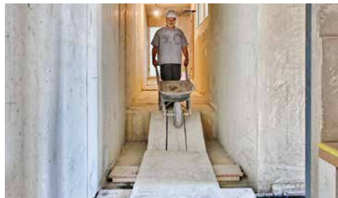
Vie di circolazione transitabili nonostante la presenza di dislivelli nell'edificio
